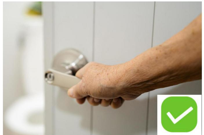
Gambar 7. Menggunakan pegangan pintu berbentuk tuas
