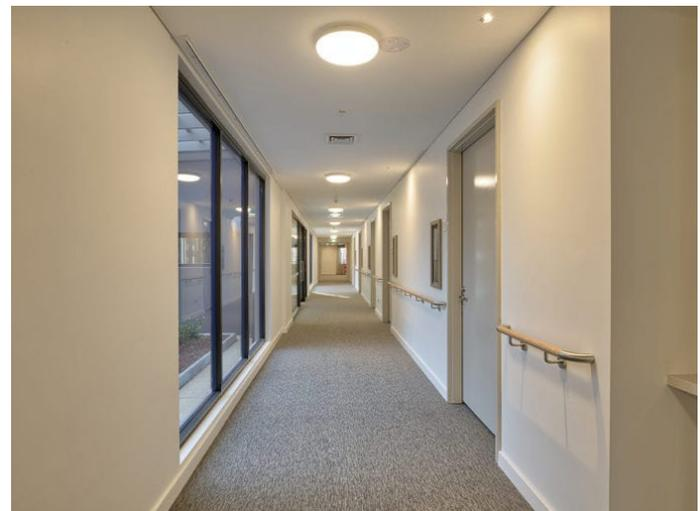
Gambar 2. Pegangan tangan (*handrail*) yang dipasang di dinding koridor rumah dengan diterangi cahaya alami matahari dan penerangan buatan dari lampu
